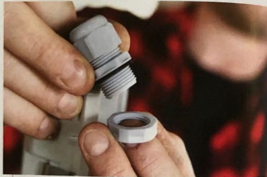
De elektradraden die de lichtbak in worden gebracht, gaan eerst door een wartel.
