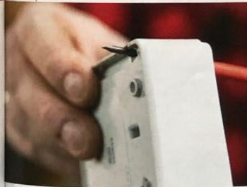
De elektradraden die de lichtbak in worden gebracht, gaan eerst door een wartel.
