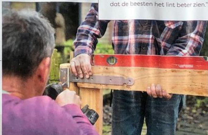
Een waterpas helpt om het hekje horizontaal te monteren.
