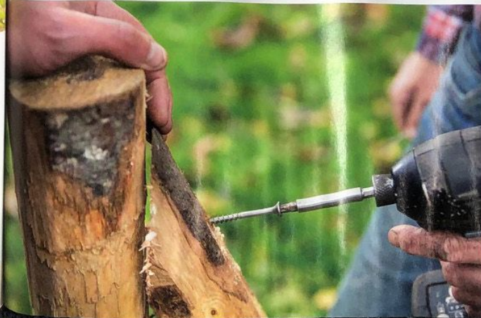
Een lange schroef volstaat om de schoorpaal te bevestigen.
