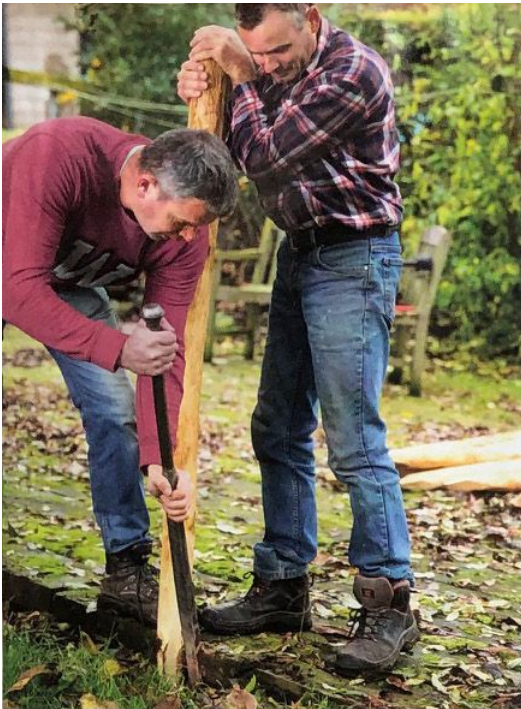
Ido en Willem hebben soms een stootijzer om door wat puin in de grond te komen.
