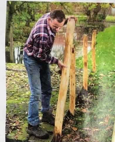
Met de palen op anderhalve meter afstand is de omheining voldoende stevig.
